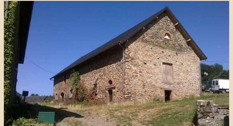
La grange à rénover
